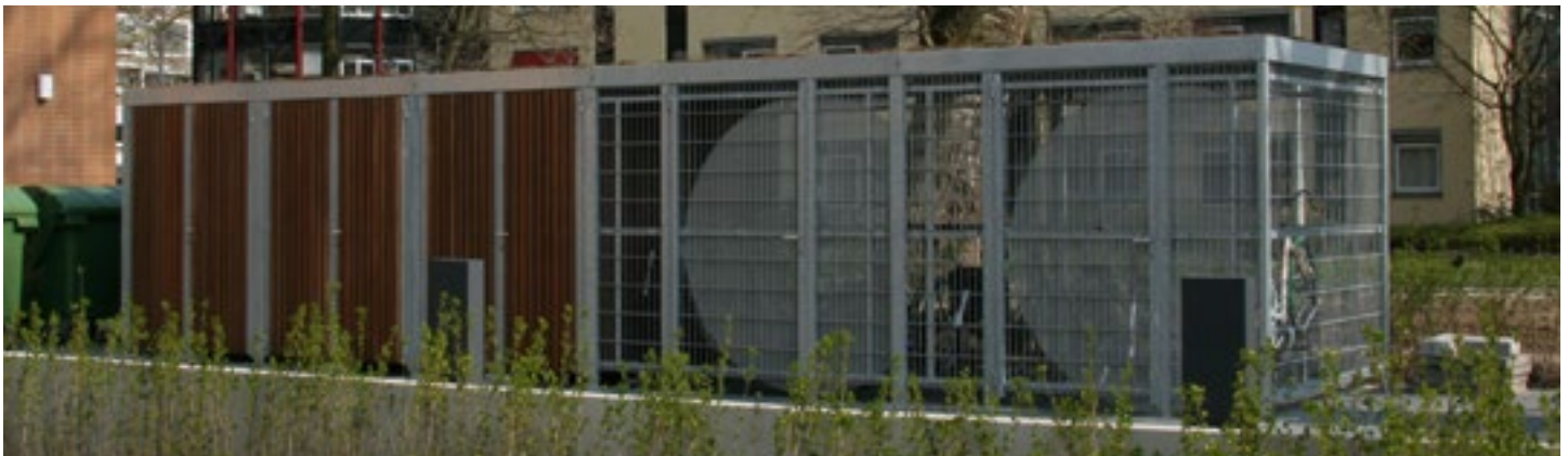
Wände verkleidet mit geschlossenen vertikalen Latten und Gitterpaneelen
