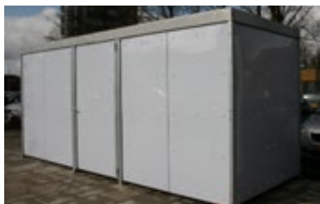
Wände verkleidet mit opalem Polycarbonat
