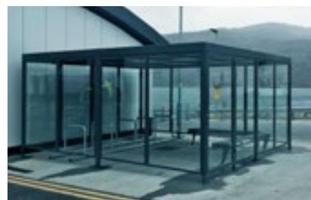
Wände verkleidet mit Sicherheitsglas
