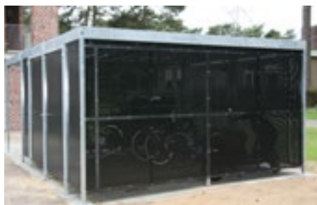
Wände verkleidet mit Lochblech, schwarz pulverbeschichtet
