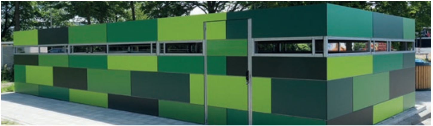
Wände mit Trespa-Platten verkleidet
