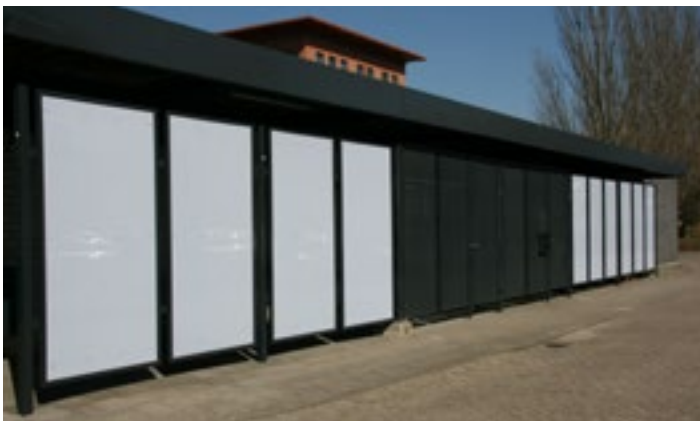
Wände verkleidet mit opalem Polycarbonat und Türen mit Lochblech in RAL
