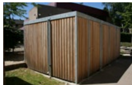
Wände verkleidet mit offenen vertikalen Latten
