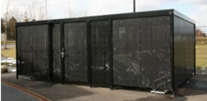
Wände verkleidet mit Lochblech, komplett pulverbeschichtet
