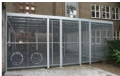
Wände verkleidet mit Pressgitter
