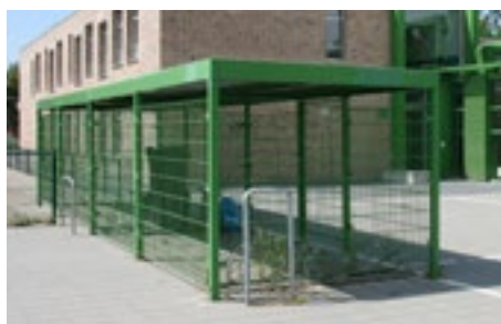
Stahlkonstruktion pulverbeschichtet
