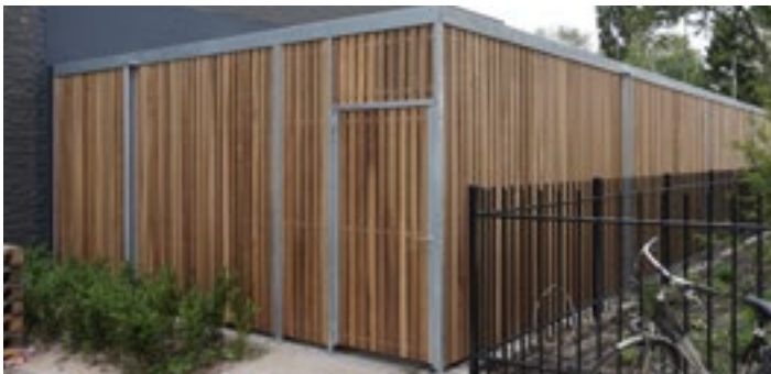
Wandverkleidung aus offenen, vertikalen Latten
